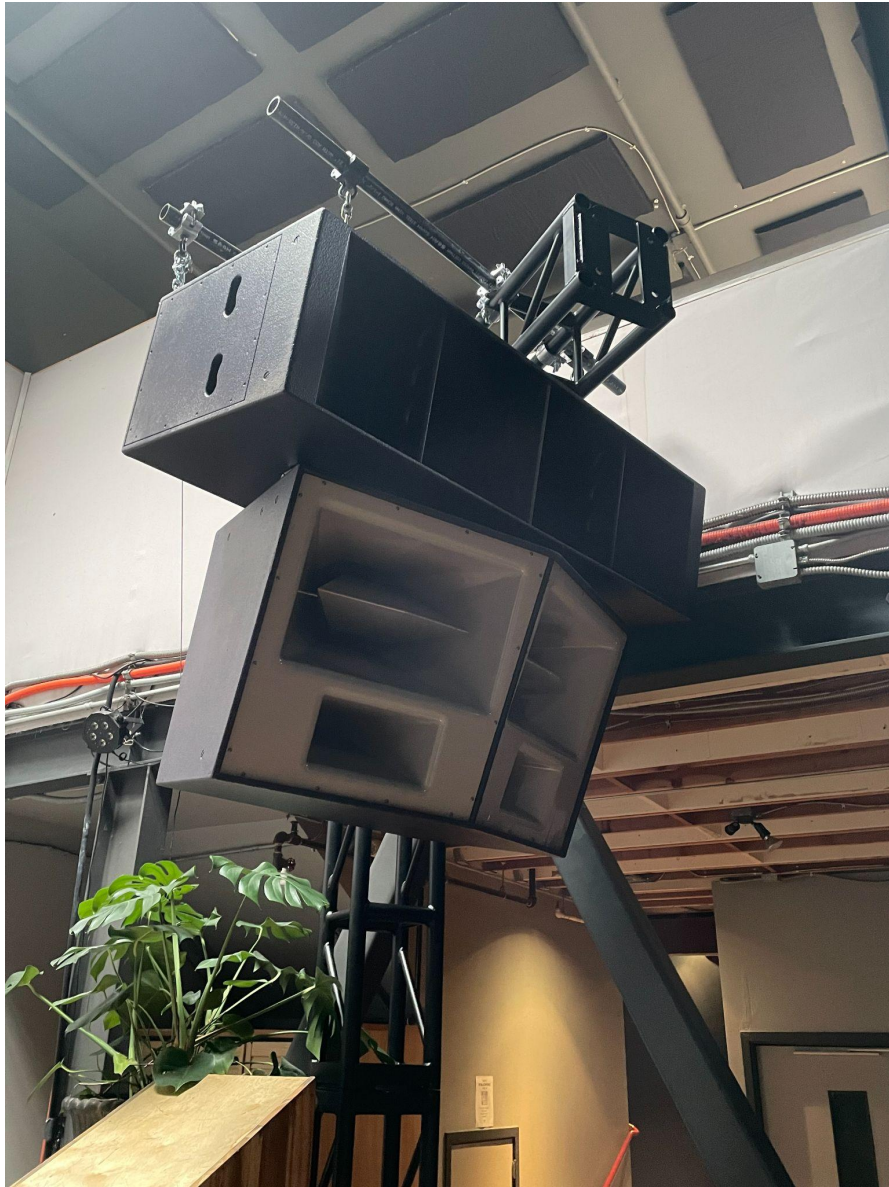
Funktion-One F315 Lows Funktion-One DS210 Evo Mid/Highs
